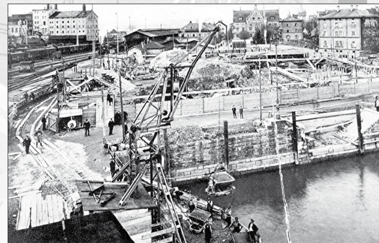
Die Bauarbeiten an den Fundamenten in der Südwestecke des kommenden Bahnhofs im Winter 1913/1914.
